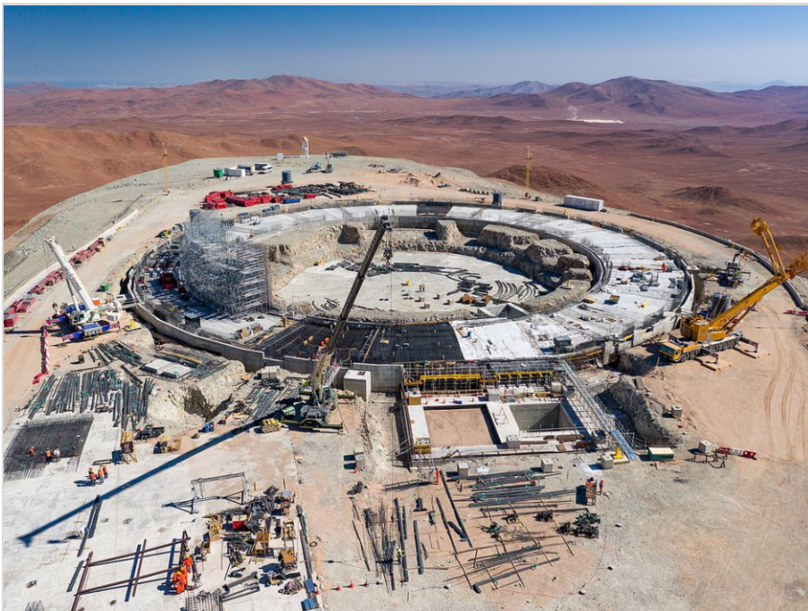
Abb. 1: Baustelle des ELT im ESO am 31. 1. 2022 auf dem 2644 m hohen Cerro-Armazones-Plateau. Koordinaten: 24° 35' 20" S, 70° 11' 32" W Bild: G. Hüdepohl (atacamaphoto.com) / ESO
