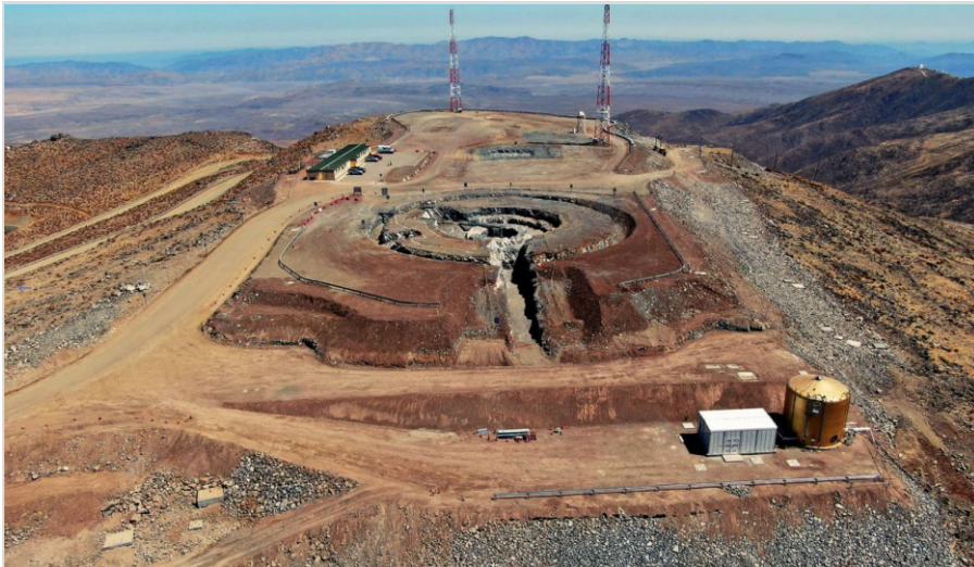
Abb. 4: Baustelle des Giant Magellan Telescope (GMT) Im Hintergrund Meteorologische Türme für Wetterdaten. Die Freifläche hier ist ausreichend für ein zweites Teleskop diese Klasse. Koordinaten: 29° 02' 53" S, 70° 41' 0,8" W. Bild: Giant Magellan Telescope – GMTO Corporation.
