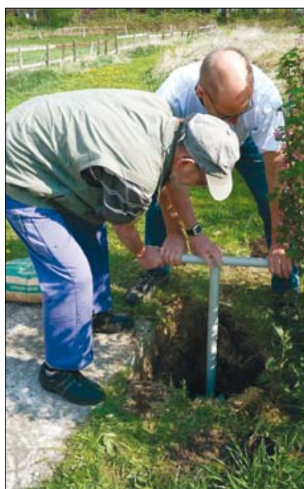
Abb. 3: Die Bohrung für die Säule.
