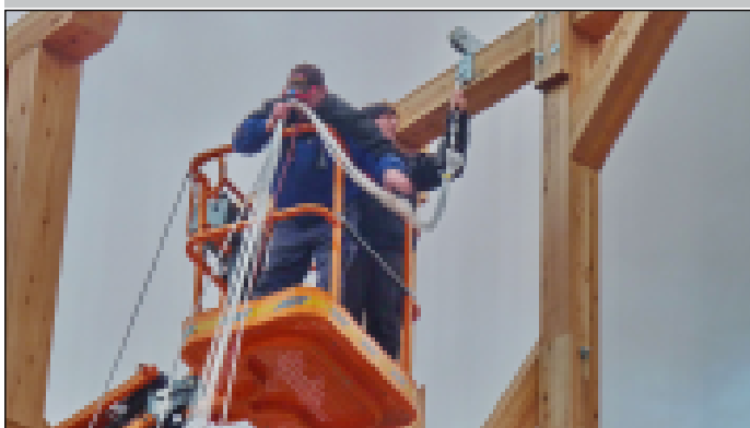
Abb. 9: Montage der Rollen.
