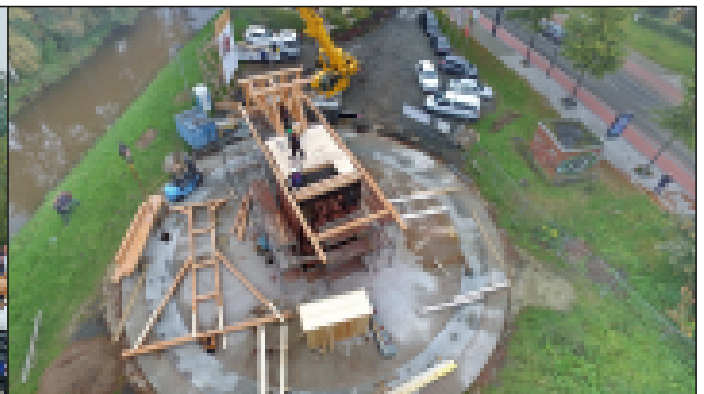
Abb. 6: Richtarbeiten aus der Sicht eines Kopters. Bild: Zimmererei von Lütken, OHZ.
