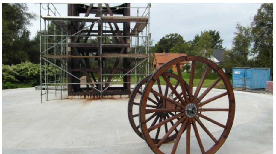
Abb. 1: Ein Räderpaar im gelieferten Zustand mit unterschiedlichen Durchmessern auf der Bahn des heutigen Telescopiums. Die Achse zeigt radial auf den Mittelpunkt des Turmes. Raddurchmesser groß 2,00 m, klein 1,70 m. (Eigenes Foto vom 15. 9. 2015).
