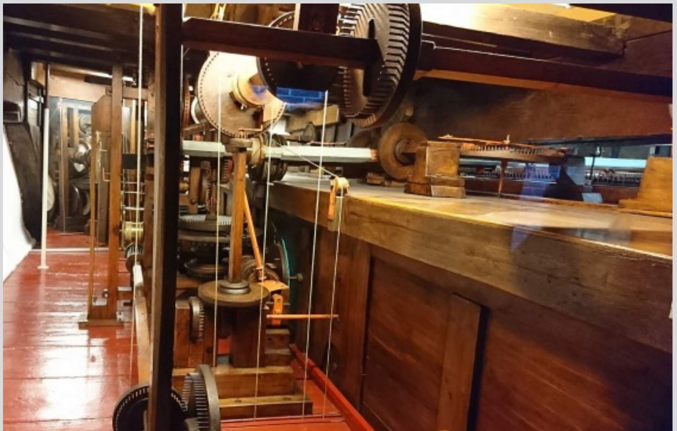
Abb. 4: Das eindrucksvolle Räderwerk unter dem Dach - der Antrieb
