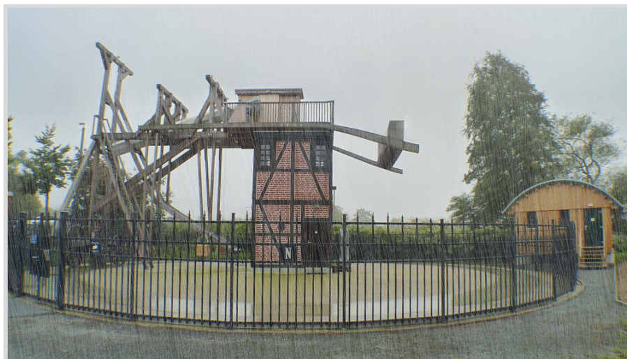
Abb. 1: Telescopium in einem Dauerregen von 2017. Damals waren die Balken noch nicht so stark „aufgeweicht“ wie hier zu sehen. Doch wenn es weiter so regnet wie bisher ist das vielleicht möglich. Ein Wenig Satire von H.- J. Leue.
