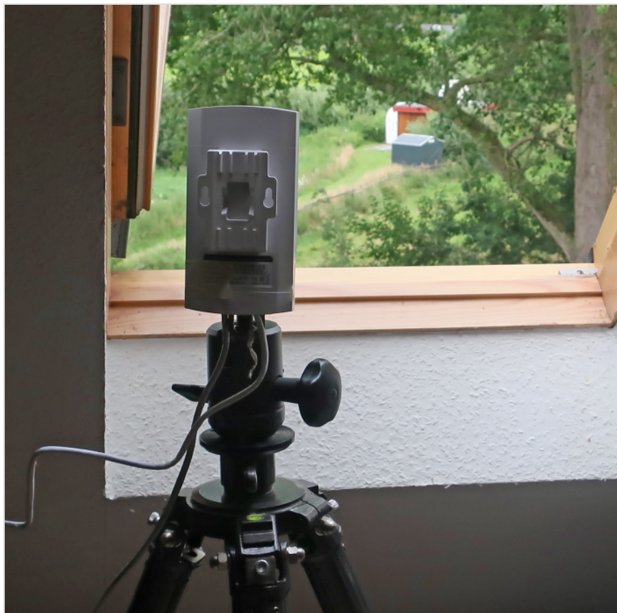
Abb. 1: Provisorischer Aufbau des Richtfunk-Senders auf dem Dachgeschoss des Vereinsraums.
